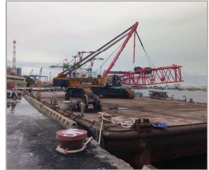
SA LAN (TÀU ĐẶT CẦU) 19x62x3.45m DECK BARGE OF (CRANE TRAFFIC) 19X62X3.45m
